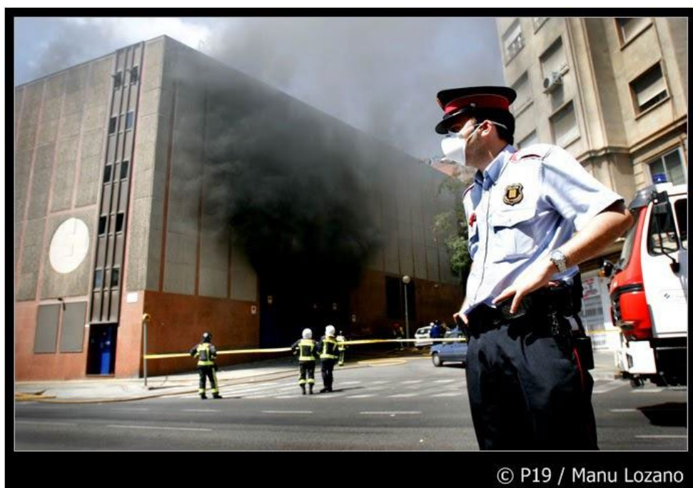
Incendio de la subestación de Maragall, 23 de julio de 2007
